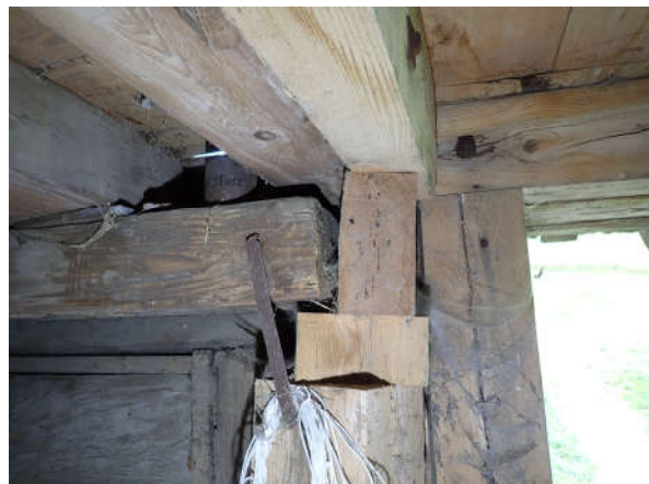
Abbildung 47: Detail ostseitige Abstützung der Fahrbahn. Unaufgeräumte Situation, fehlender Kraft- und Formschluss. Äusserst bescheidene handwerkliche Ausführung in der zweiten Hälfte des 20. Jahrhunderts.
