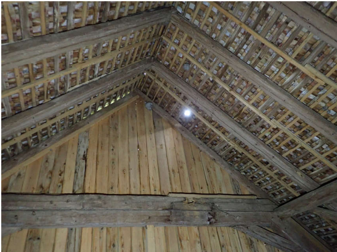
Abbildung 20 a+b: Die Dachfläche im Bereich der eingeschossigen Binder, mit Stuhlwandrähm, Andreaskreuzen und Riegel. Oberhalb der Binder gibt es weder Windstreben noch Firstpfette. Auf dem Bild unten erkennt man das reine Sparrendach oberhalb der Stuhlwände ohne jegliche verstärkende Einbauten und Längsaussteifung.
