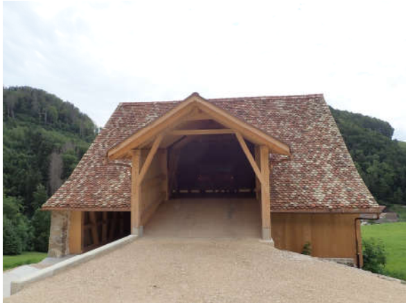
Abbildung 10: Ostfassade mit grossflächigen Einflugkorridoren.
