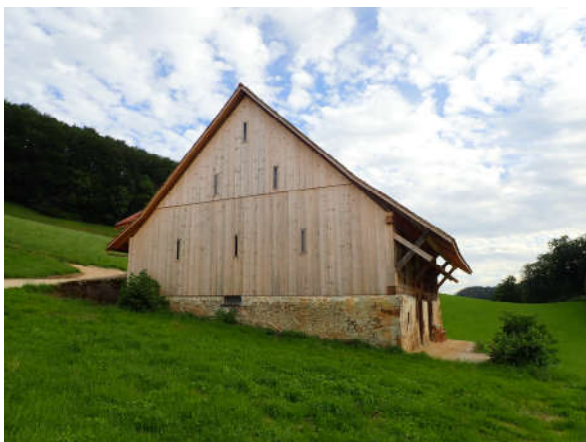
Abbildung 72: Ansicht Nord: Umsichtig gestaltete Giebel- fassade mit typischer Einteilung der Lüftungs- und Belichtungsschlitze.
