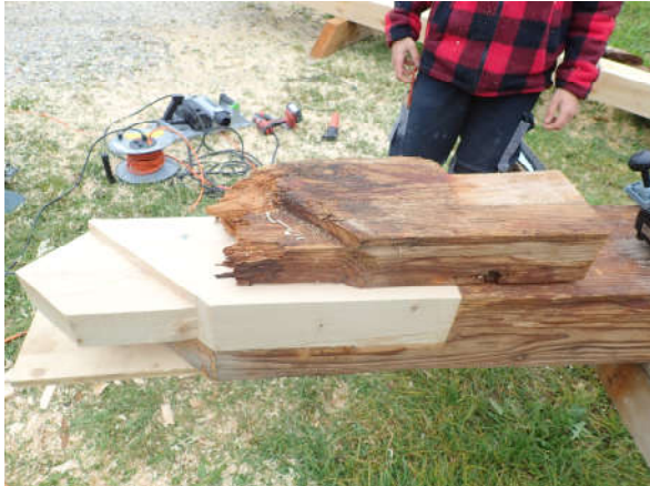
Abbildung 58: Eingesetztes Reparaturstück an einem Strebenfuss.
