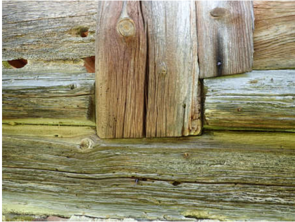
Abbildung 16: Durch die Schiefstellung der Bohlenständerwände des 1. Geschosses verursachte, einseitige Druckstauchungen bei den Pfostenauflagern der Wandschwellen.
