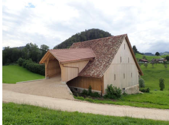
Abbildung 11: Ansicht Nord-Ost Ecke.
