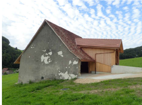
Abbildung 75: Südfassade mit lokalen Kalkputzflicken. Die verwitterte Fassade wurde absichtlich nur repariert. Der Substanzerhalt gebietet einen sorgsamen Umgang mit dem Bestand, gleichzeitig erleichtert eine poröse Bruchsteinmauer die Besiedlung durch Fluginsekten.
