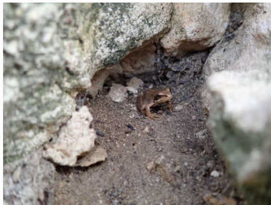
Abbildung 9: Mauernische am Mauerfuss der Nordfassade inkl. Bewohner.
