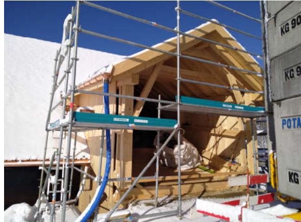
Abbildung 65: Erneuter Schneefall im Januar 2021, wieder ist die Baustelle unterbrochen, das Einfahrdach mittlerweile fertig erstellt.
