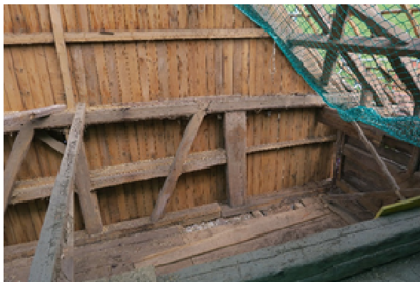
Abbildung 30: Nachträglich in die Nordwand eingesetzte Streben sollten das Obergeschoss oberhalb des Heubodens stabilisieren.
