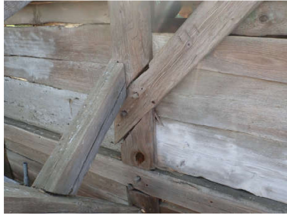
Abbildung 17: Verklaffungen und Quetschungen am Schwalbenschwanzblatt der aussteifenden Kopfbänder als Folge der Schiefstellung.
