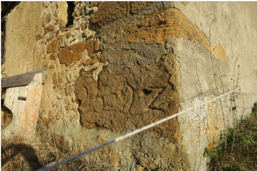
Abbildung 29: An der Südwestecke ist die Jahrzahl 1692 zu erkennen.
