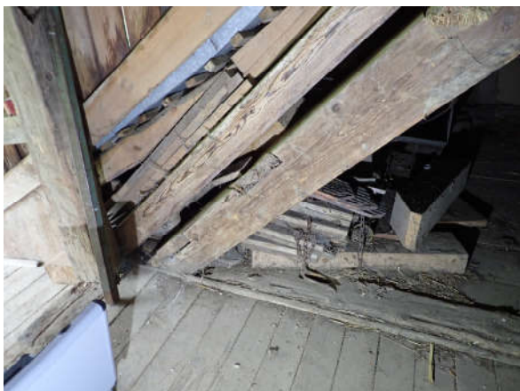
Abbildung 48: Unaufgeräumte Situation Bundbalkenkopf am ostseitigen Dachfuss vor der Freilegung. (Vergleiche Abb. 41)
