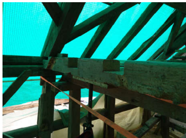
Abbildung 49: 50% Querschnittsverlust am Bundbalken infolge stümperhafter Eingriffe im 20. Jahrhundert. Der Bundbalken musste komplett ausgewechselt werden.
