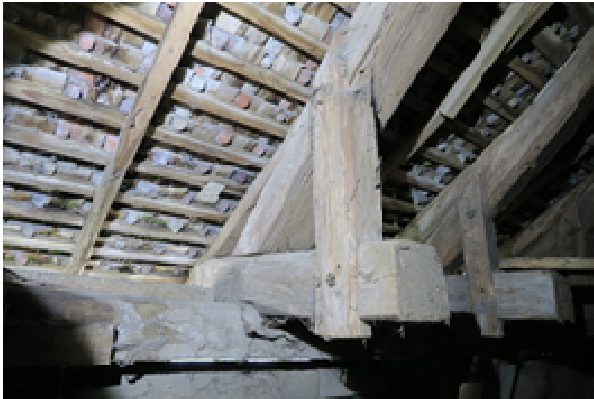
Abbildung 22: Sparrenknechte Dachfuss Ost.
