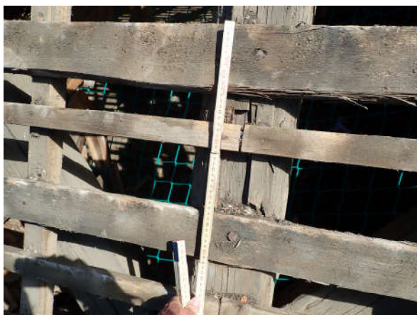
Abbildung 34: Ursprüngliche Ziegellattung mit einzelnen eingestreuten neueren Latten.
