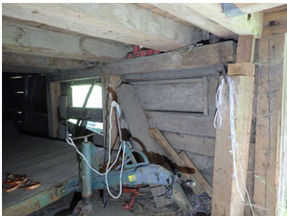
Abbildung 46: Grossansicht der ostseitigen Abstützung der Hocheinfahrt. Was trägt hier eigentlich was?
