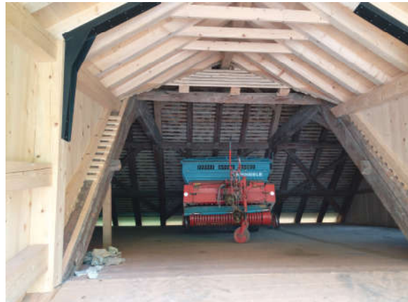
Abbildung 67: Eingestellter Heuladewagen im fertiggestellten Dachstock der Saaleggscheune.
