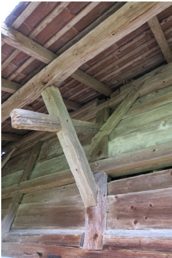
Abbildung 14: Detail der Westseite und Vordachkonstruktion. Bundpfosten mit minimaler horizontaler Verstrebung.
