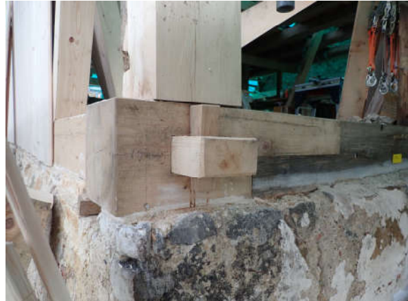
Abbildung 59: Wiederhergestellte Holzverbindung: Zapfenschloss an Grundschwelle des Mauerauflagers der Holzkonstruktion.
