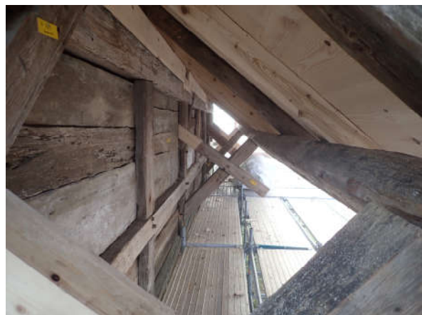
Abbildung 63: Blick in das Vordach West und die instand gestellte Bohlenständerwand.
