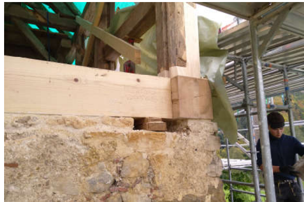
Abbildung 55: Instand gestellte Ecke Nordost, Aussenansicht mit ertüchtigtem Mauerauflager.
