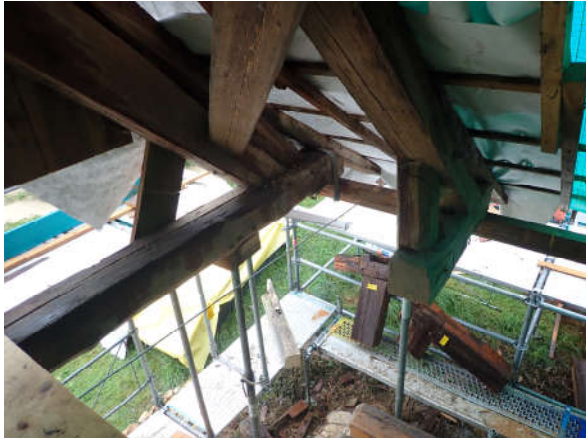
Abbildung 52: Der „schwebende“ Dachfuss Ost: Unterhalb des abgehobenen Dachstuhls laufen die Arbeiten an den Umfassungswänden des 1. Obergeschosses.
