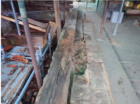
Abbildung 44: Befund nach der Freilegung: Totalverlust Wandschwelle Ost.
