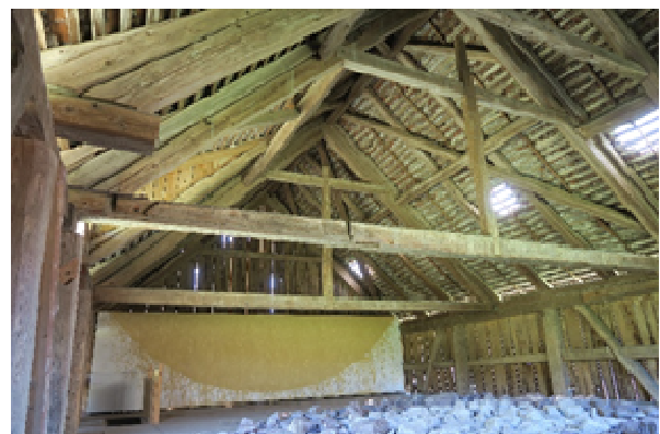
Abbildung 19: Aufhängung der Binderbalken in der Scheune Schindelmatt/Kehrweid (34.10).
