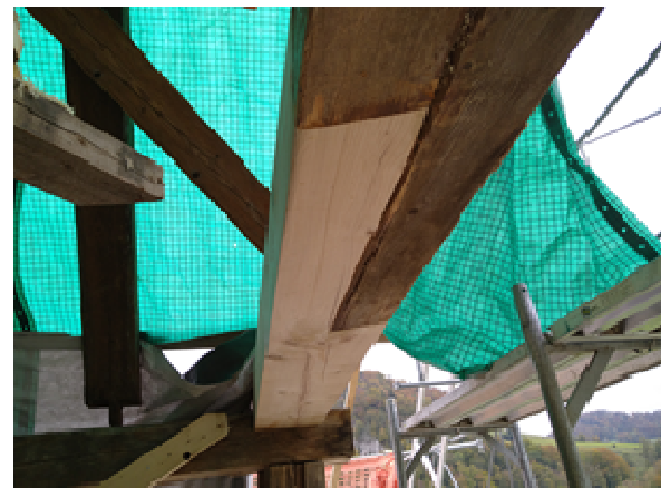
Abbildung 57: Anschäftung Bundbalkenkopf Nordost: Die Zugverbindung ist wieder hergestellt.
