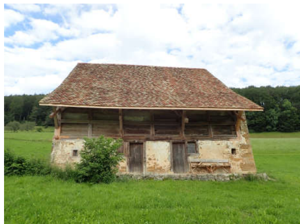
Abbildung 73: Das Schmuckstück: Westfassade mit bau- zeitlicher Bohlenständerwand mit Flugpfettenkonstrukti- on und Inschrift.
