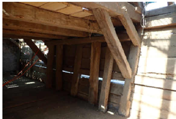
Abbildung 31: Zusätzliche und längere Büge für die Binnenbinder sollten die Neigung zur Talseite hin aufhalten.
