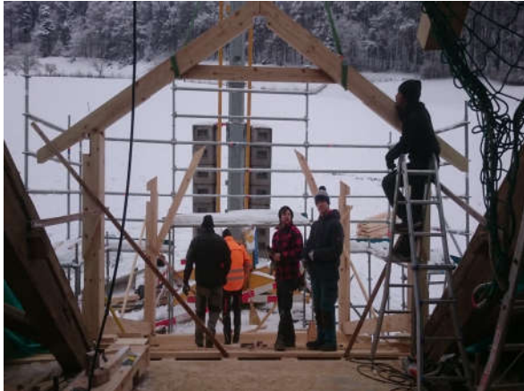
Abbildung 64: Wintereinbruch Anfangs Dezember 2020, das Einfahrdach wird montiert.
