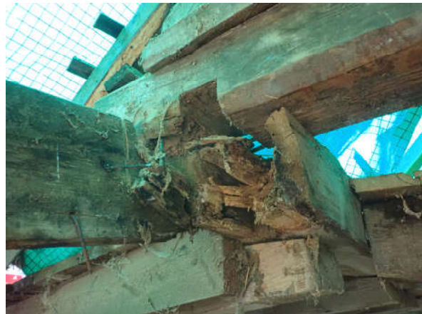
Abbildung 42: Befund nach der Freilegung: Totalschaden am Bundbalkenaufleger des ostseitigen Rähms der Traufwand. Es herrschte Einsturzgefahr.
