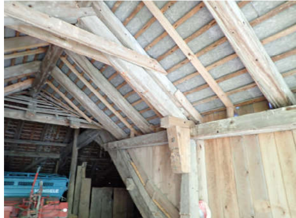
Abbildung 45: Ansicht der Querversteifungsfragmente der Einfahrt. Um den Durchfahrtskorridor zu erweitern, wurde der Querbinder der Einfahrtskonstruktion herausgeschnitten. In der Folge neigte sich die gesamte Einfahrtskonstruktion gegen Osten.
