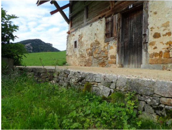
Abbildung 4: Trockensteinmauer Westfassade.
