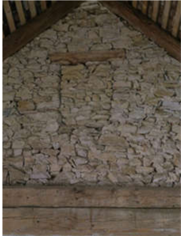
Abbildung 28: Die Giebelspitze entspricht der Flucht des Dachstuhls.
