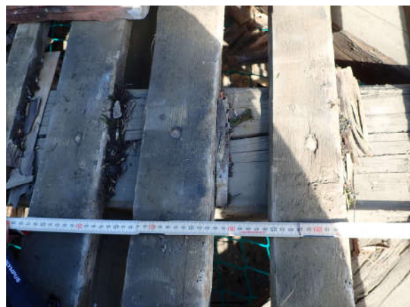
Abbildung 35: Ursprüngliche Lattung mit Sprungmass 17-18 cm.
