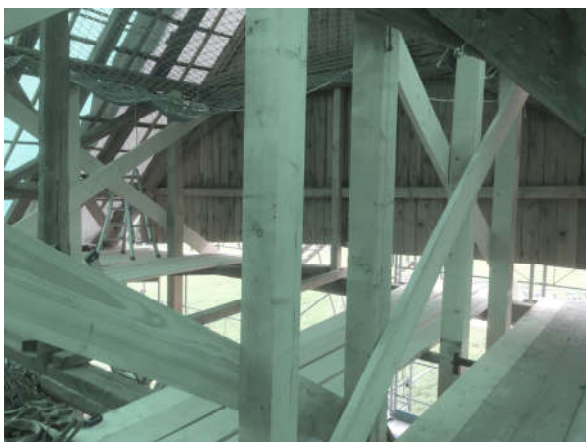
Abbildung 50: Blick in den komplett vom Unterbau abgehobenen Dachstuhl.
