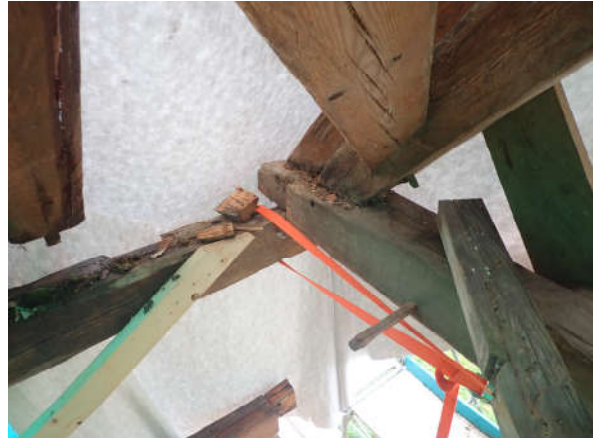
Abbildung 53: Der „schwebende“ Dachfuss West: An den allseitig zugänglichen Bundbalkenköpfen laufen die Er-tüchtigungs- und Reparaturarbeiten. Die Bundbalken „binden“ das Gebäude zusammen und sind unerlässlich für die Gesamtstabilität der Konstruktion.
