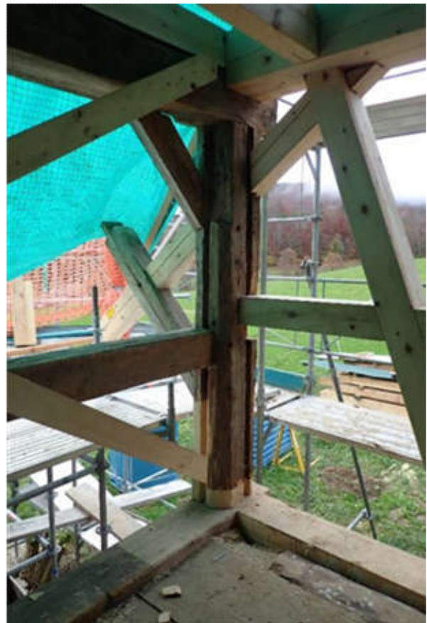
Abbildung 15: Eckpfosten, ursprünglich nur durch zwei kurze Büge verstrebt.
