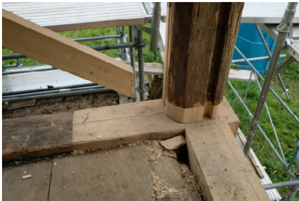
Abbildung 54: Instand gestellte Eckverbindung Nordost. Innenansicht.
