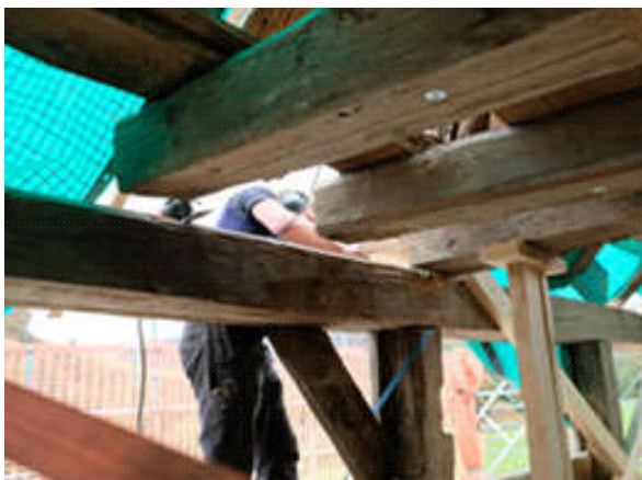
Abbildung 56: Instandstellungsarbeiten an der Bohlenständerwand. Die Wand ist entlastet und kann ausgerichtet werden.
