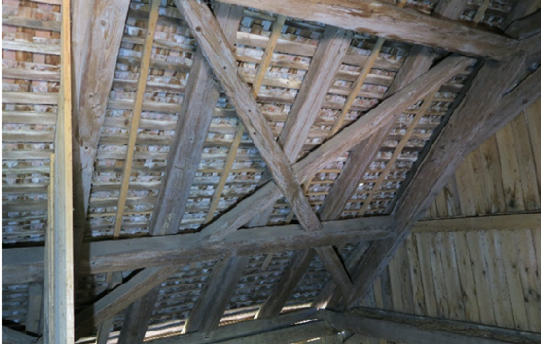
Abbildung 20 a+b: Die Dachfläche im Bereich der eingeschossigen Binder, mit Stuhlwandrähm, Andreaskreuzen und Riegel. Oberhalb der Binder gibt es weder Windstreben noch Firstpfette. Auf dem Bild unten erkennt man das reine Sparrendach oberhalb der Stuhlwände ohne jegliche verstärkende Einbauten und Längsaussteifung.
