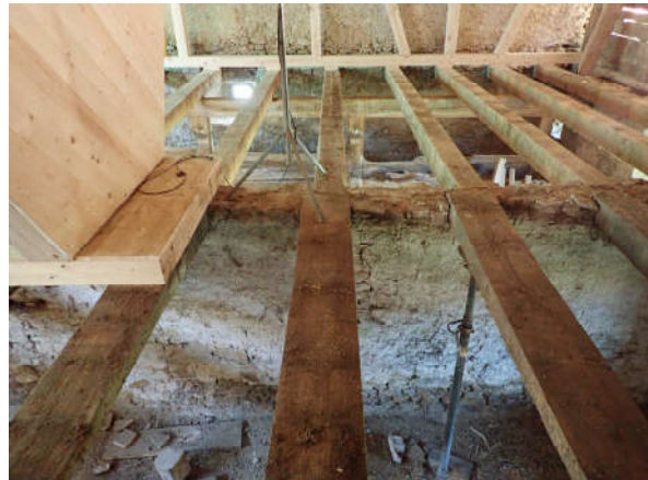
Abbildung 61: Balkenlage über Stallgeschoss. Der ehemalige Heuboden wird ersetzt, die Balkenlage ertüchtigt.
