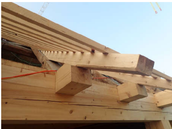
Abbildung 62: Dachfuss Ost, nach der Instandstellung.
