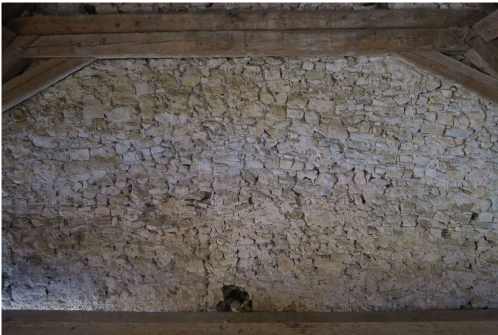
Abbildung 26: Die Südwand mit zur Mitte hin ansteigenden Mauerschichten und zwei dicht beieinander liegenden stumpfen Mauerfugen.
