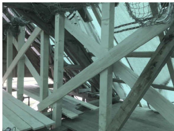
Abbildung 51: Der aufgestelzte Dachstuhl stabilisiert gleichzeitig die Giebelwand. Auskreuzungen und Verstrebungen gewährleisten die Stabilität während der Bauphase.
