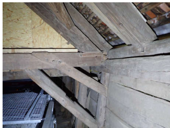
Abbildung 40: Detail Dachfuss West Feldbinder: Sämtliche Kontaktflächen (Vorholz) der Holzverbindungen, welche auf Zug belastet waren, hatten versagt. Der Dachfuss drohte auch hier gegen aussen wegzurutschen.
