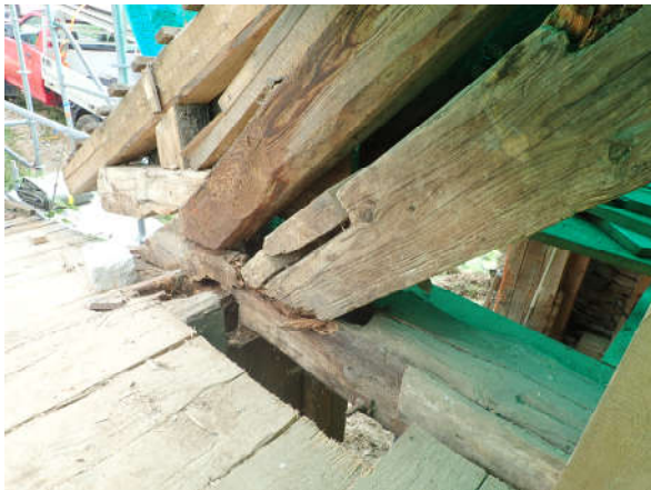
Abbildung 41: Befund nach der Freilegung: Totalschaden am Bundbalkenkopf am ostseitigen Dachfuss. Das Bauteil hatte die Versagensgrenze überschritten.
