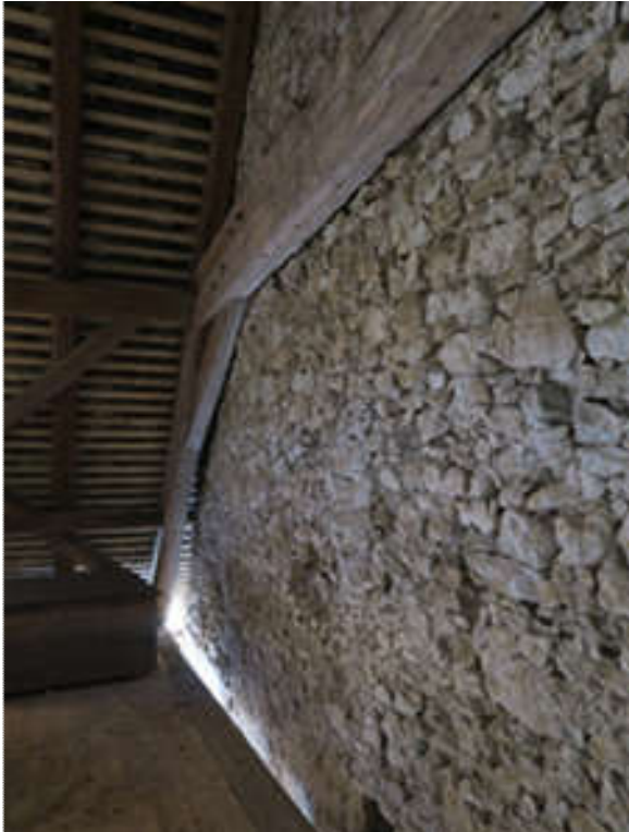
Abbildung 27: Die Flucht der Mauer entspricht nicht der Flucht des Bundbalkens.
