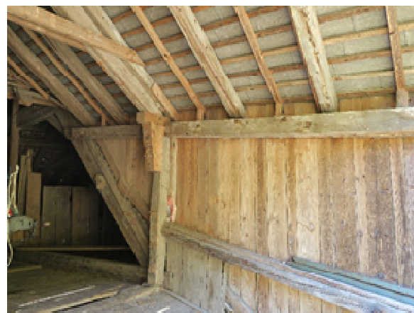
Abbildung 33: Der Zugang zur Hocheinfahrt mit Fragmenten der ehemaligen Firstabstützung, die im 20. Jahrhundert der Durchfahrtshöhe geopfert wurde.
