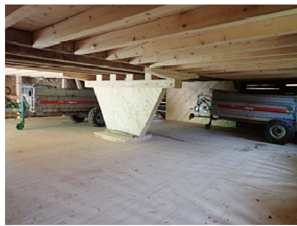
Abbildung 69: Eingestellte Anhänger im Obergeschoss der Saaleggscheune.
