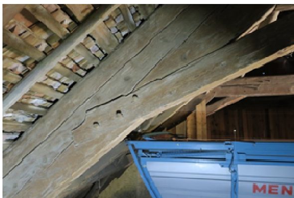
Abbildung 18: Eines der mit grosser Sorgfalt ausgeführten Blätter der Querbünde.
