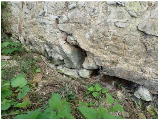
Abbildung 8: Nischen am Mauerfuss Nordfassade. Nur statisch relevante Mauernischen wurden ausgeflickt.
