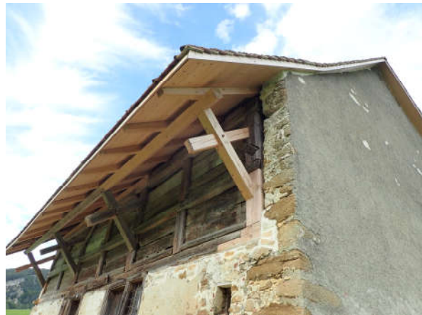
Abbildung 77: Die restaurierte Bohlenständerwand.
