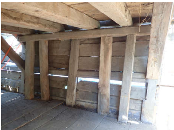
Abbildung 32: Die Abstützung der Hocheinfahrt wurde als Sekundärkonstruktion vor die Bohlenständerwände montiert. Bild: Westseite.
