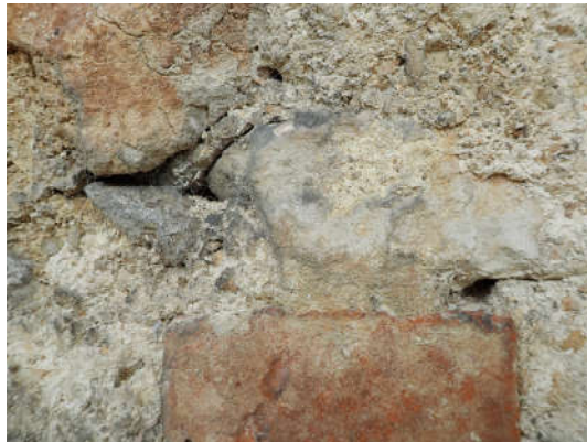
Abbildung 7: Poröses Bruchsteinmauerwerk mit Insektenausfluglöchern in den Kalkmörtelflächen.
