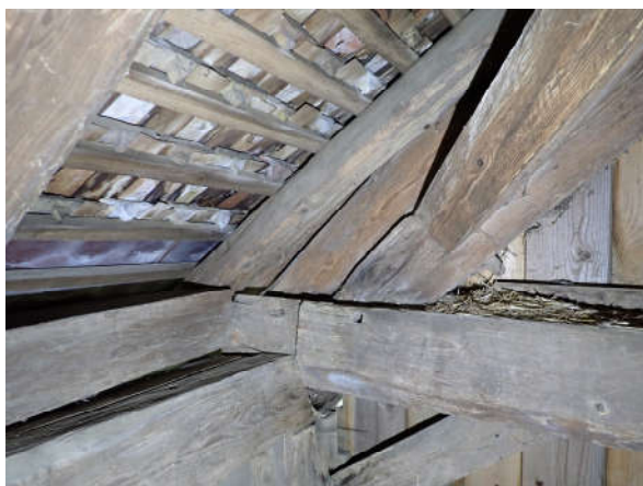
Abbildung 39: Detail Dachfuss West Randbinder: Die Verbindung der Sparrenschwelle zum Bundbalken hatte komplett versagt, die Sparrenschwelle war 18 cm über das Wandrähm hinausgewandert. Die Sparrenfüsse konnten die Dachlasten nicht mehr in den Unterbau einleiten, es herrschte Einsturzgefahr.
