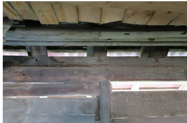
Abbildung 23: Sparrenschwelle Dachfuss West.
