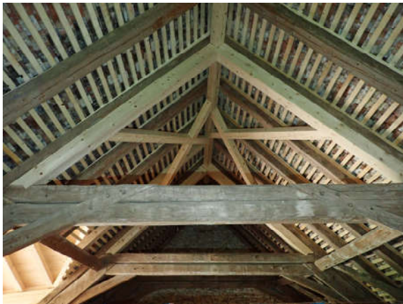
Abbildung 76: Blick in den ertüchtigten Dachstuhl.
